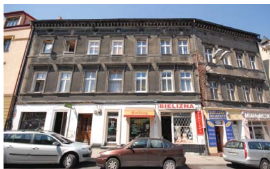
Budynki czekają na renowację.
