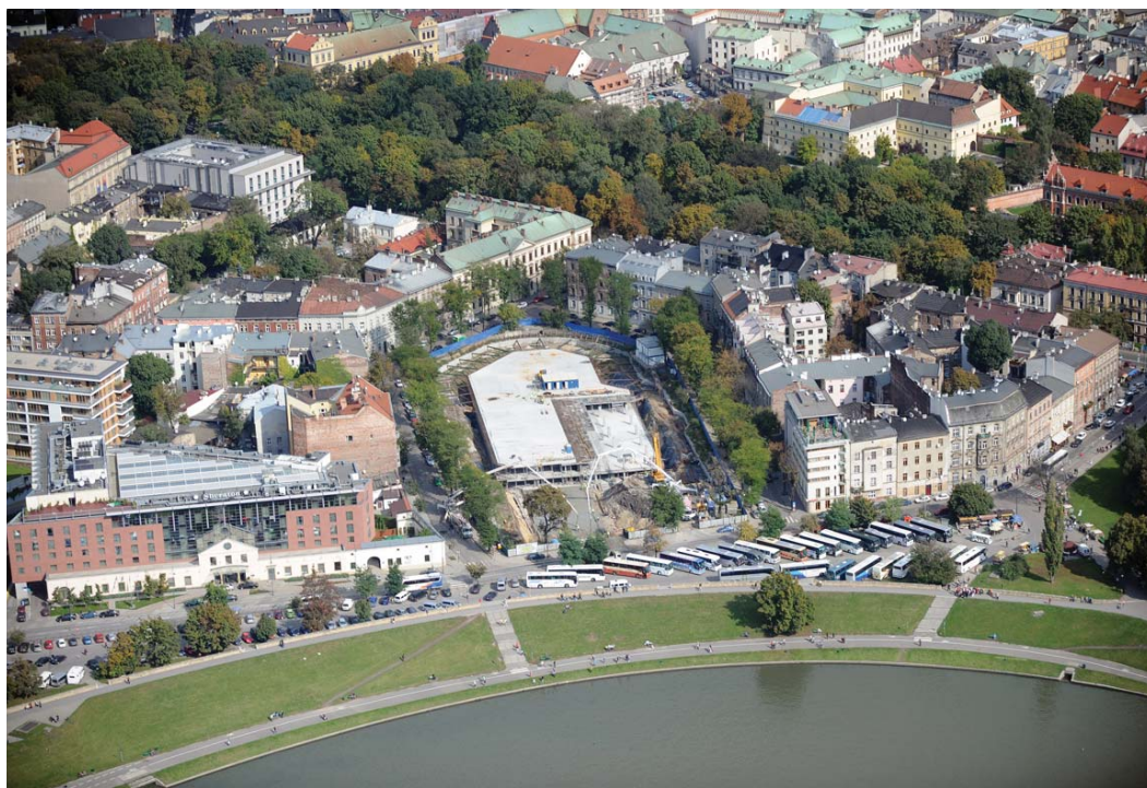
Prace budowlane nabrały już kształtu - wrzesień 2008.
