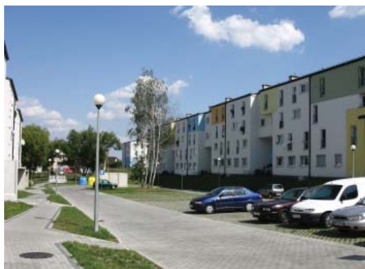
Budynki przy ul. Magnolii, oferowane w ramach Programu Zamian
