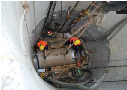
Budowa kolektora deszczowego metodą mikrotruningu w rejonie Dworca Łódź – Kaliska.
