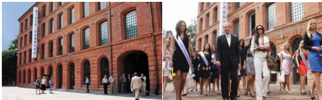
Zrewitalizowana fabryka Geyera. Fot. archiwum UMŁ
