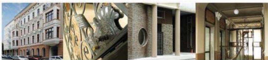
Zrewitalizowana kamienica przy ul. Sienkiewicza 67.
